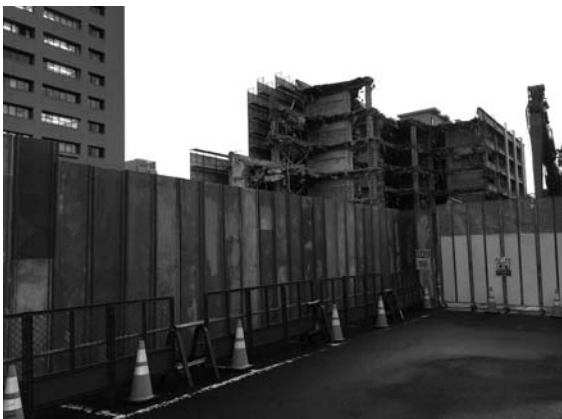
写真1 解体中の被災校舎(2017/10)
