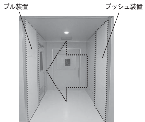
図2 漏洩防止プッシュプル装置の例
